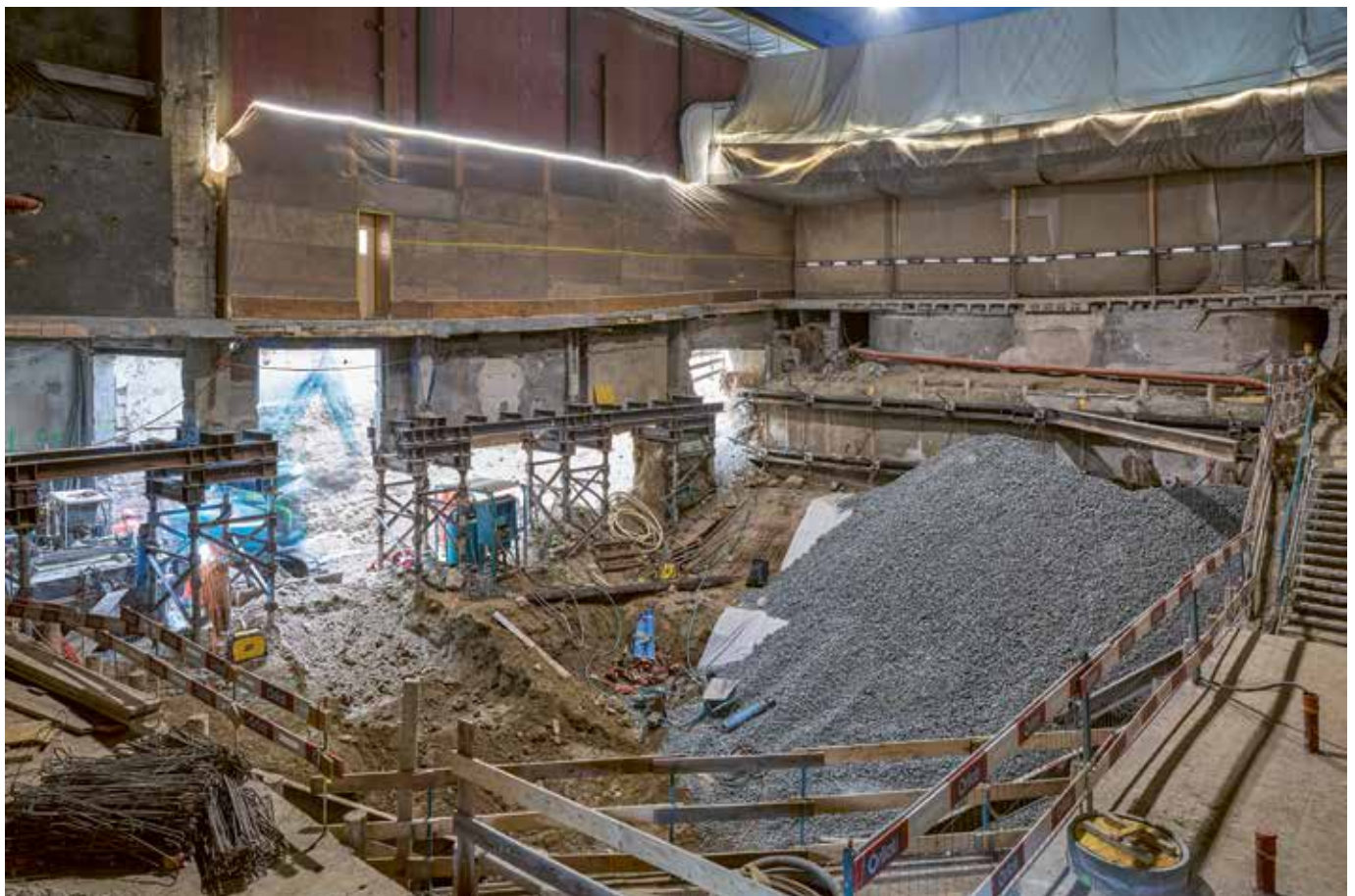
Le titanesque chantier d'excavation pour la création de la Petite Salle sous la Grande Salle (NICOLAS PRAHIN)
