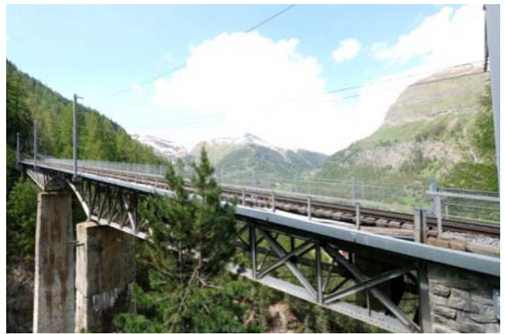
Findelbachbrücke 2018 (Photo architectum 2018)
